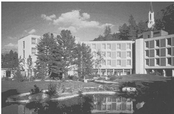
Fig. 3. La sede delle terme di St. Moritz Bad. Fonte: foto dell'autore.
