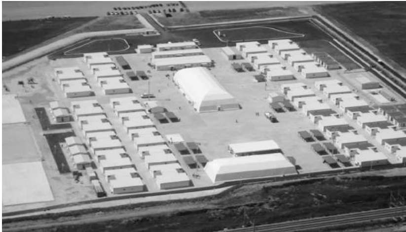
Foto 1. Vista aerea del C.A.R.A. di Bari-Palese. Il Centro è costituito da 124 moduli prefabbricati costruiti intorno ad una grande cupola di tela usata come mensa e sala comune.
