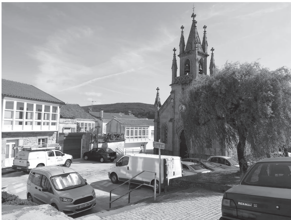
Fig. 1. Plaza de la iglesia como aparcamiento en Corcubión
