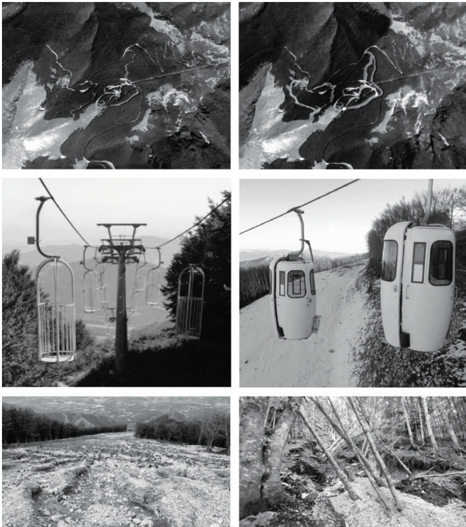
Fig. 1. In alto, immagini satellitari del 2016 e del 2018, il confronto evidenzia i massicci interventi realizzati. Al centro la vecchia cestovia (foto del 2009) e la nuova cabinovia inaugurata nel febbraio 2019. In basso le piste dopo l'alluvione del settembre 2022: ruscellamenti, canali-fossati, trasporto di ghiaia e sradicamento di alberi nell'area compresa tra la strada provinciale 105, la pista di fondovalle, i rifugi Gorghe e Cotaline.
