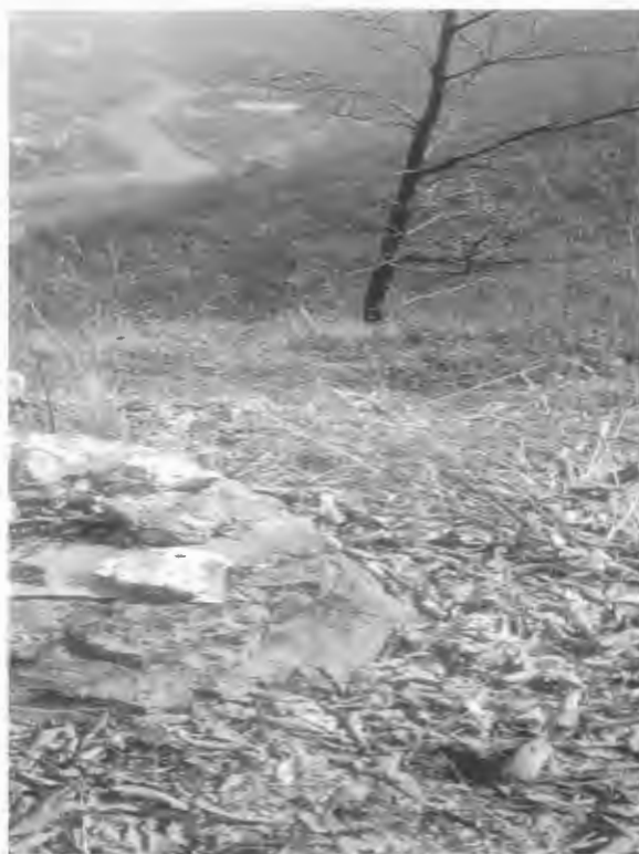
Fig. 5. Imbocco di pozzo-cisterna interrato su piano terrazzato sopra Oliero (Valstagna): l'abbandono ha portato al deperimento funzionale anche di ingegnosi sistemi di captazione e raccolta dell'acqua (Foto Varotto, 2000).
