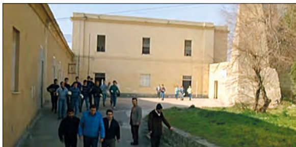
Fig. 11. La struttura detentiva e le rovine della torre Piccolomini.
