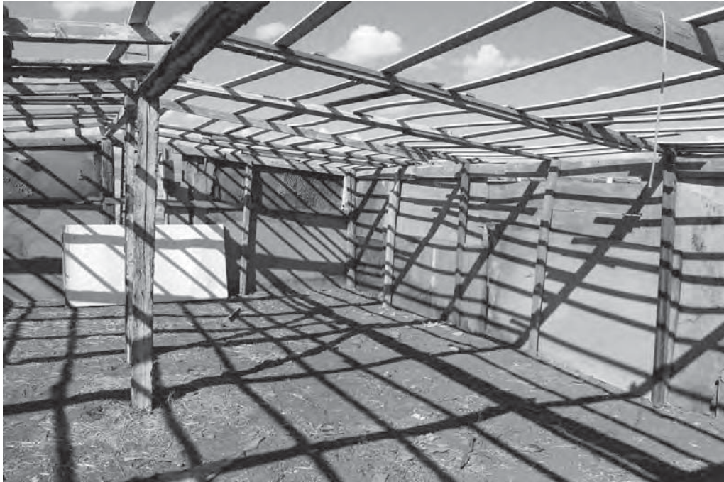
Fig. 3 – Baracca per dormitorio in fase di costruzione nel Gran Ghetto. Luglio 2013. Fonte: foto dell'Autrice.
