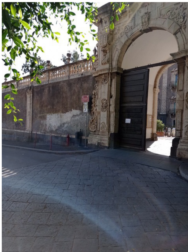
Figura 2. Entrata e particolari di atti vandalici del Monastero dei Benedettini di San Nicolò l'Arena (CT), costruzione 1558-1866. Foto dell'autrice.
