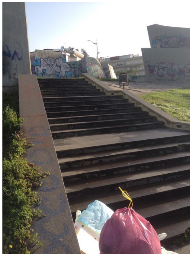
Figura 3. Monumento commemorativo bellico ai Caduti «Vortice» – progettazione arch. G. Marino, CT. Particolare di atti vandalici ed incuria. Foto dell'autrice.
