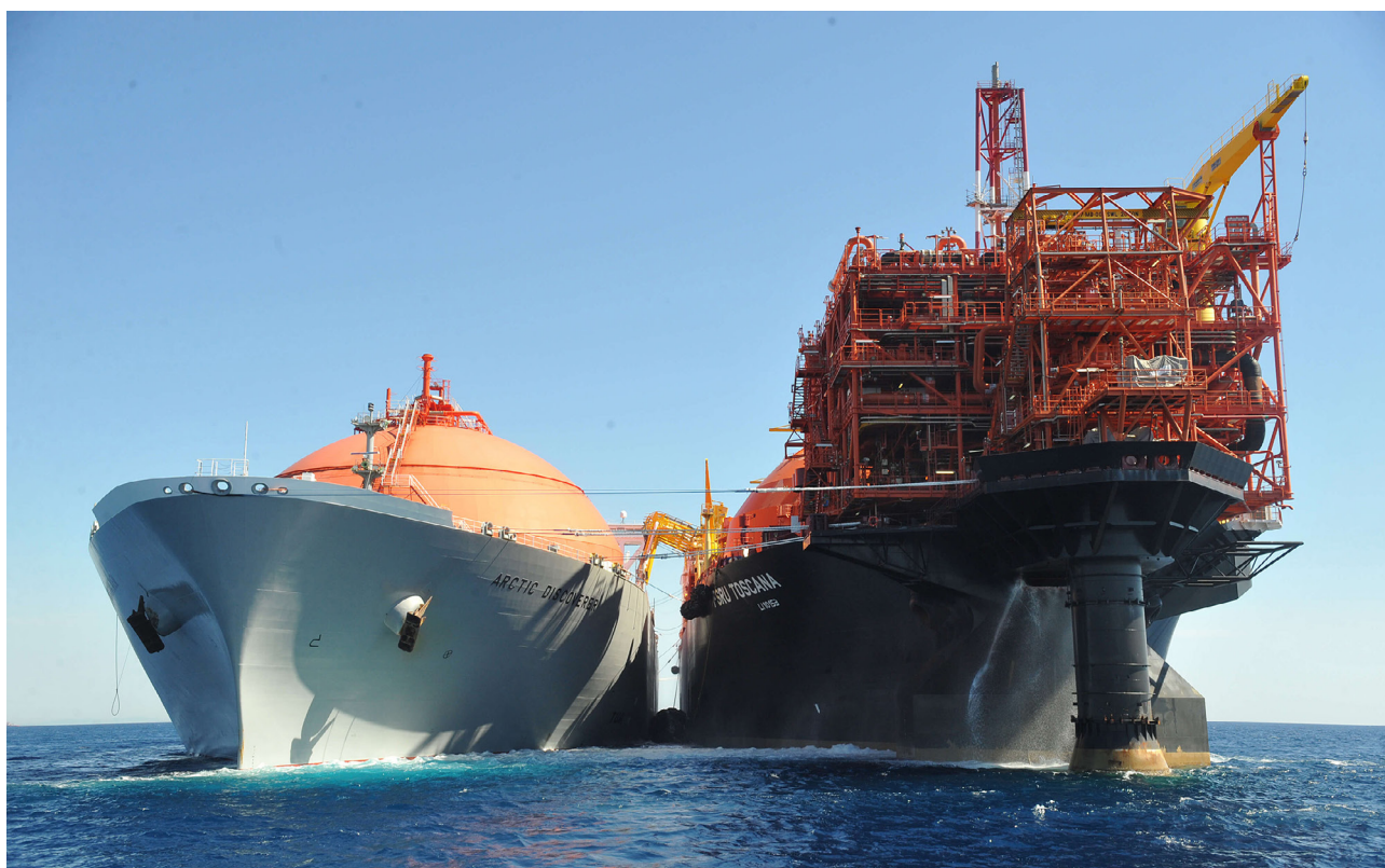
Figura 1. Il rigassificatore con affiancata una nave gasiera mentre scarica il GNL – Gas Naturale Liquefatto. Fonte: www.oltoffshore.it/media/galleria-media .
